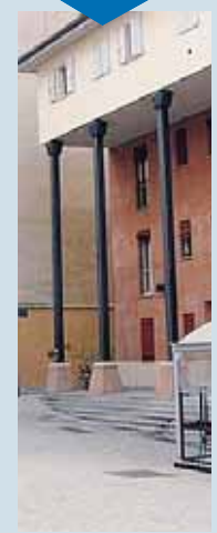
Nelle foto alcune vedute della Manifattura delle Arti
